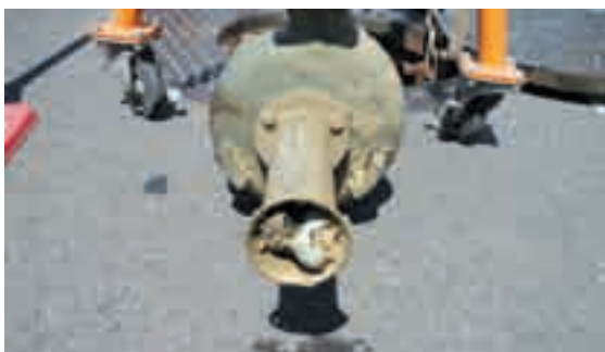
ポンプに異物が絡んでいる様子。このようになるとポンプが停止するため、除去作業が必要になります。
