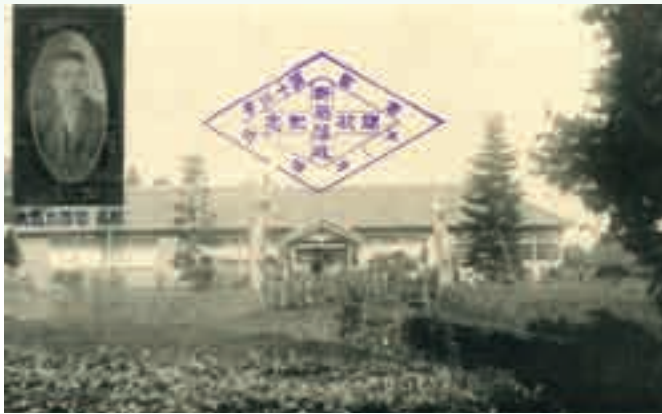
菱田小学校明治43年の新築校舎
