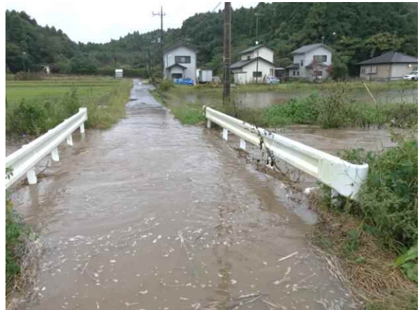
台風によって浸水する高谷川
