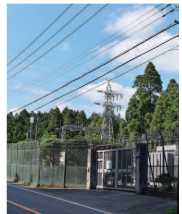
▲小池地区変電所
