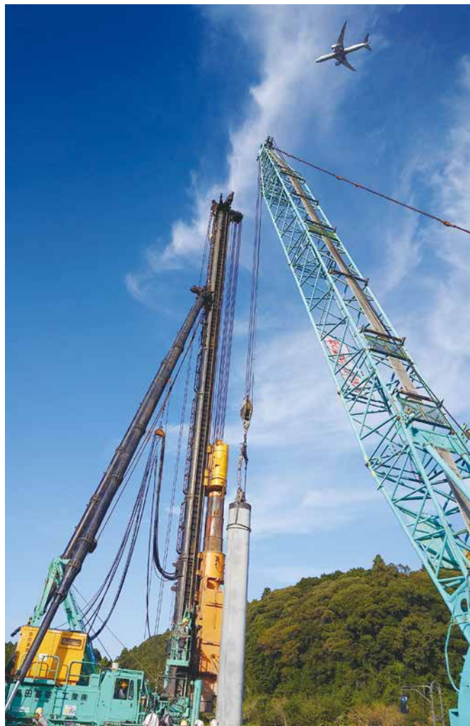
▲トンネル下部の補強作業
