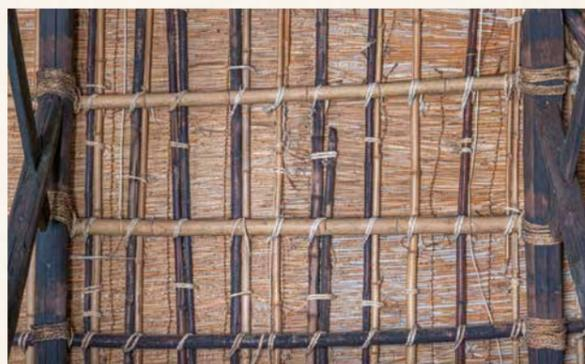
土間から上を見上げると屋根裏が見えます。屋根裏は屋根材がむき出しになっている家が多かったそうですが、旧藪家住宅は屋根材の下によしずが敷いてある丁寧な作りになっています。
