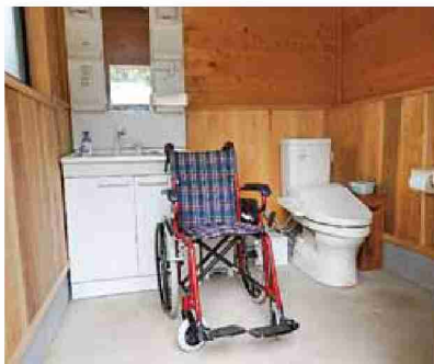
トイレの改築 (総工費約100万円)
