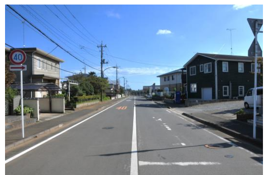
はにわ台住宅団地
