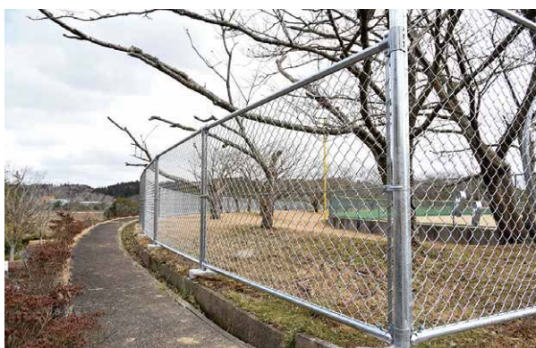
交換された外周フェンス
