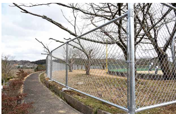
交換された外周フェンス
