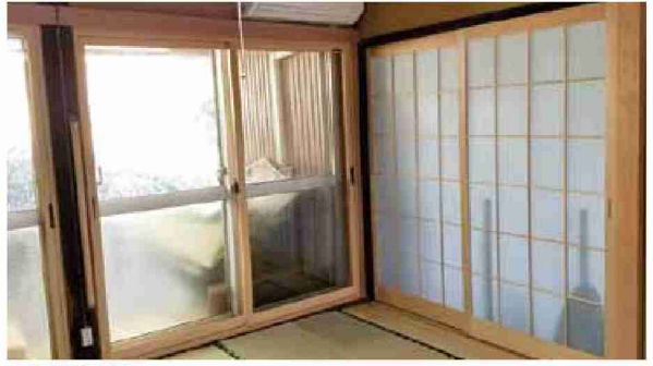
内窓設置事業
