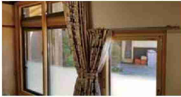
完成した内窓
