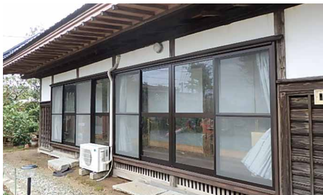
再防音工事施工
