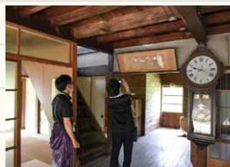
▲旧笹喜旅館の建物状況調査(建物内部・外部)
