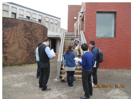
劣化状況調査の様子
