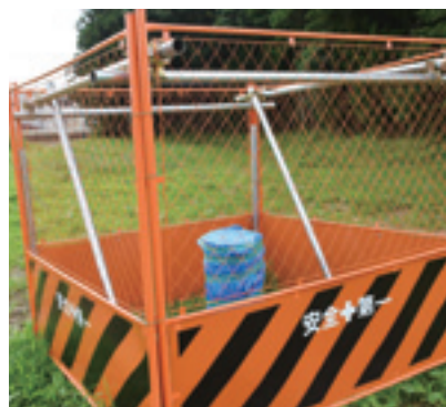
▲水道事業の先駆けとして掘削された大台井戸
