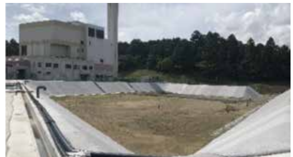
▲かさ上げ工事が完了し、令和14年度までの埋め立てが可能となった「最終処分場」 工事費は1億5393万円
