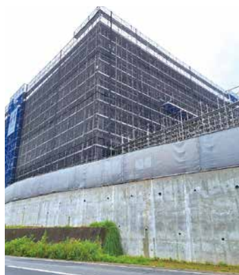
▲建設中の倉庫
