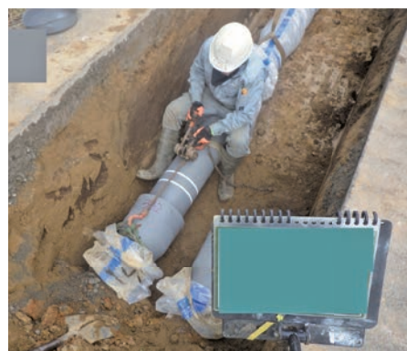
▲水道管布設工事の様子
