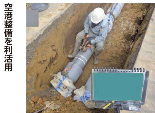
▲水道管布設工事の様子
