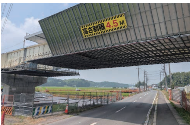
▲殿部田で工事中の圏央道が見られます
