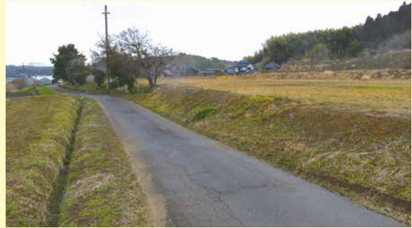
▲拡幅後は大型の消防車等も安全に通行できる。
