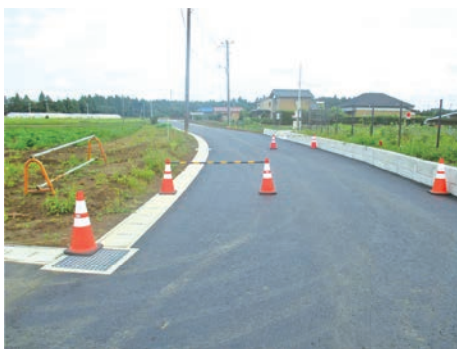
▲町道 02-017 号線道路排水整備 (新井田地先)
