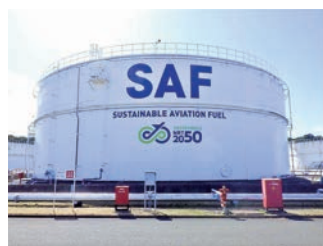
▲空港内にあるSAFタンク 提供：成田国際空港㈱
