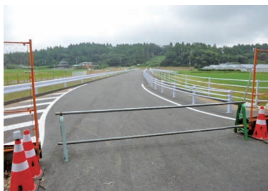
▲小池の拠点整備のための仮設道路
